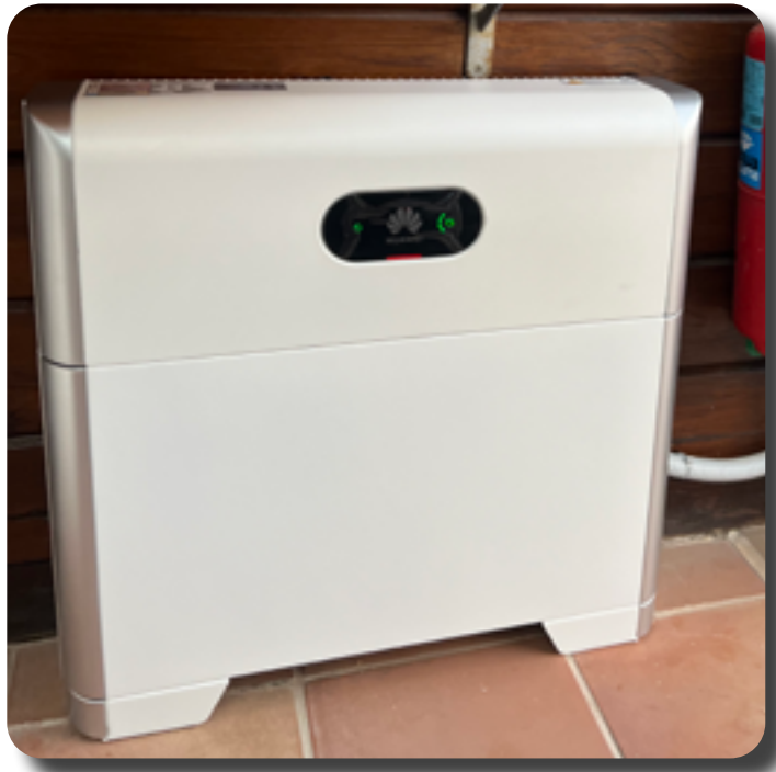
Batería Huawei con un módulo, instalada en Alcoi (Alicante).
