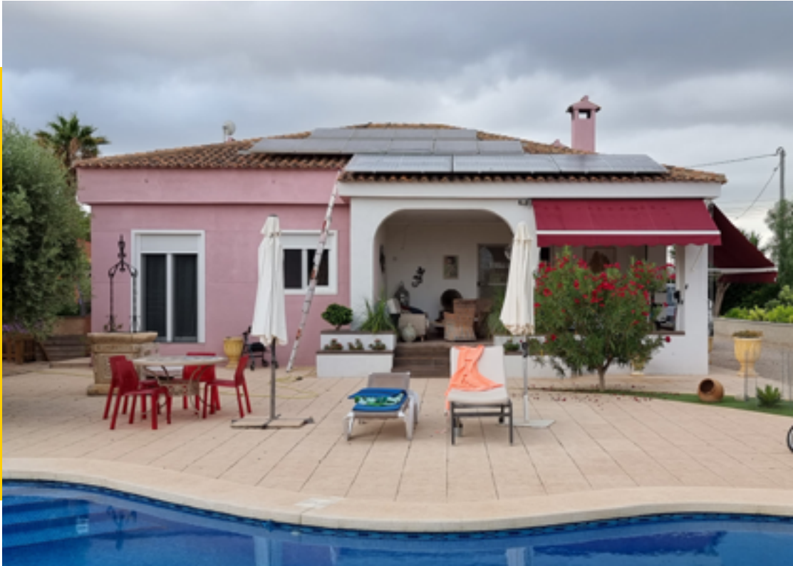
Instalación fotovoltaica ubicada en Crevillente (Alicante)
